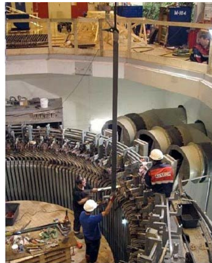
ci-dessus: montage des bobines de l'induit dans un stator de grand diamètre. document Alstom
